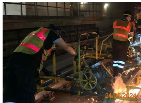
รูปที่ 2-5 การตรวจสอบและซ่อมบำรุงรางรถไฟฟ้ายางสม่ำเสมอ
