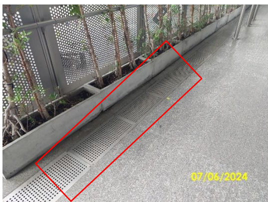
รูปที่ 2-6 ระบบระบายน้ำบริเวณพื้นที่สถานีรถไฟฟ้า
