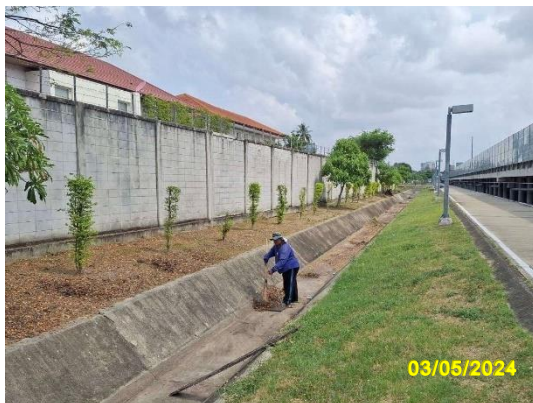
รูปที่ 2-20 การตรวจสอบ ดูแล และขุดลอกท่อระบายน้ำและบ่อกักทอระบายน้ำ ภายในพื้นที่ศูนย์ซ่อมบำรุง
